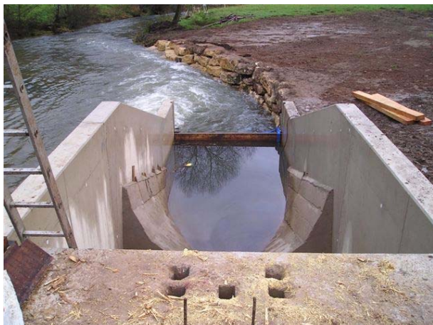
Costruzione al grezzo con presagomatura
